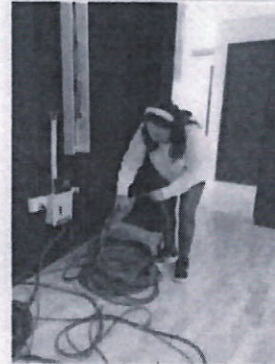
Limpeiza y orden de cableado
