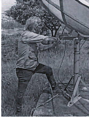
Como parte del Plan Anual de Mantenimiento 2024 se realiza revisión de anclajes de la antena
