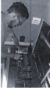
Limpeza en seco de CCUS (centro de control de unidades)
