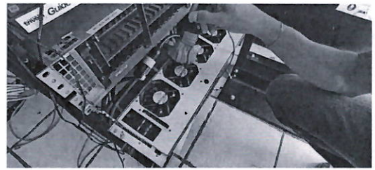
Remoción de polvo a los ventiladores del insertor de tablas
